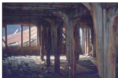
Figur 5. Avstivning med krumvokste knær. Vibrandøy i Haugesund. Foto: HS
