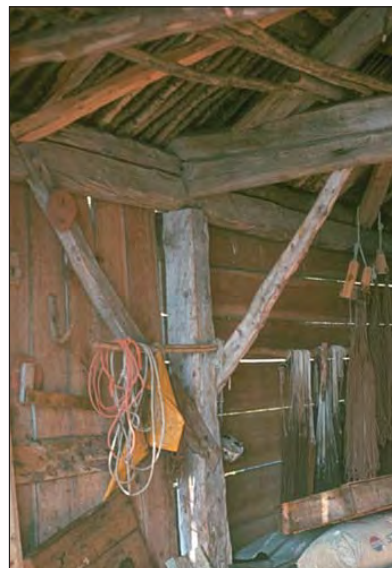
Figur 3. Naust Efjorden. Overgang vegg/tak. Foto: GJ
