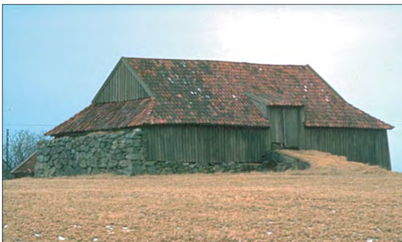
Figur 14. Løe, Grødal i Hå kommune. Foto: HS
