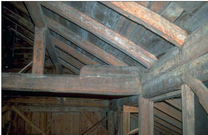
Figur 10. Detalj av bukkehus-konstruksjonen i loa på Grønnes, med dobbel bete og dobbel raftlæggje, og med raftlæggja plassert sentrisk over staven. Foto: CAS
