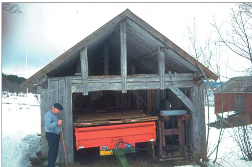
Figur 11. Båtskjå på Grønnes i Molde kommune. Bukkehus-konstruksjon, der taksperrene er understøttet av mōnsås, sideåser og åsstaver festet i rekspontspor i den doble beten. Foto: CAS
