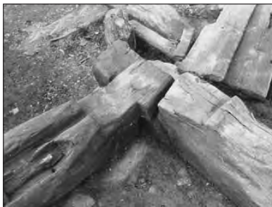
Foto 3. Bygn.177 in situ, NV-hjørne sett fra SØ Foto: Ark. inst., UiB
