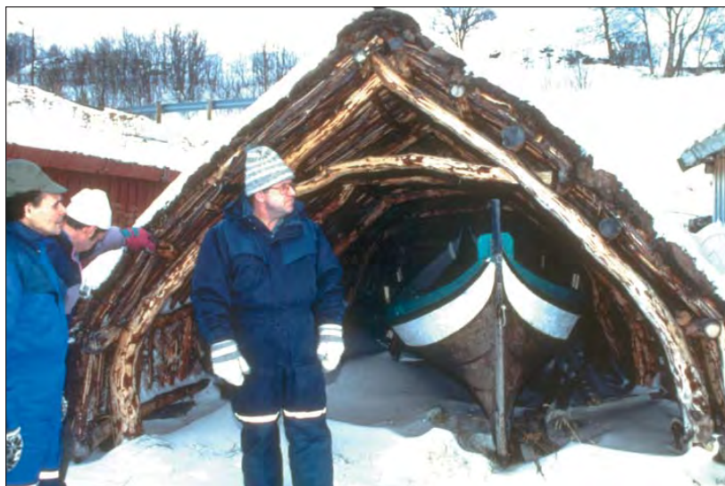
Figur 1. Båtskjul med kroksperrer som ber åstak, har stor logisk slektskap med sperreverket, det sperreborne åstaket som er ein dominerande byggjemåte nordafjells. Foto: JBG
