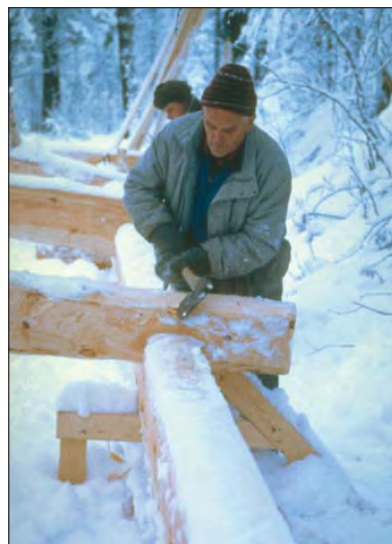
Figur 2. Ei etterlikning av naustet på Stangnes blir bygd til ein ny storfembøring ved Lofotmuseet i Kabelvåg. Vi nyttar bygginga til aktiv tradisjonsoverføring. Her ser vi Rbald Haugli i gang med eit laft som han har praktisert. Det er eit flatlaft (sekskanta hals) med (loddrett) midtstilt tapp. Laft med tapp er vanlege i vest og nord, men dei er svært lite omtala i litteraturen. Foto: JBG
