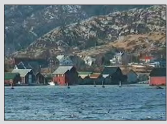
Struen, Bremanger. Saltebuer, havstover og naust, kring hamna. Bindingsverk og grindverk side om side.
