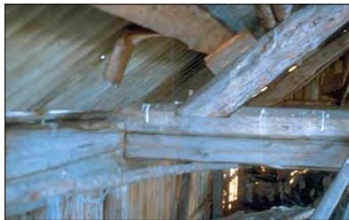
Figur 5. Brygge Myklebostad. Overgang vegg/tak. Foto: GJ
