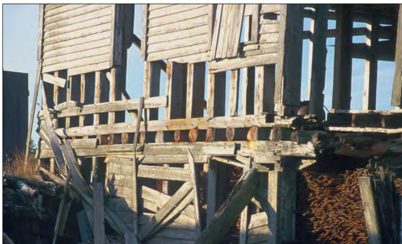
Figur 3. Bindingsverksvegg, ca. 1880. Vibrandøy i Haugesund. Foto: HS
