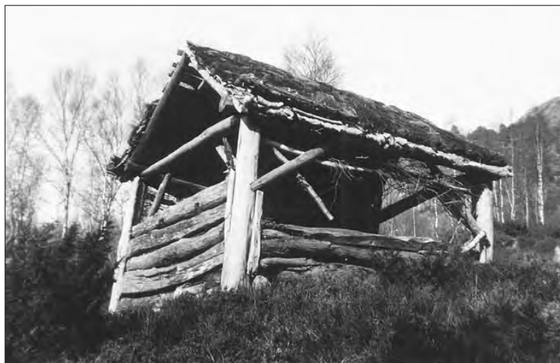
Figur 17. Uttløe med slepverksvegger «lavegger». Espedal, Forsand i Ryfylke. Foto: G. Mikkelsen.
