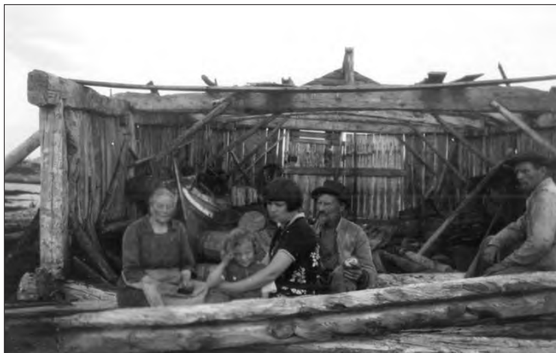
Figur 6. Fotografi frå omtrekkinga av naustet på Stangnes i 1930 syner at det var åsstavar som bar den fremre delen av taket inntil då. Foto: Ukjent.
