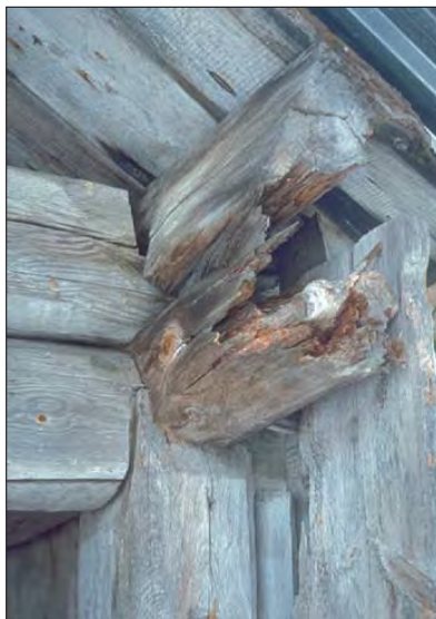
Figur 11. Båtskjå på Grønnes i Molde kommune. Bukkehus-konstruksjon, der taksperrene er understøttet av mōnsås, sideåser og åsstaver festet i rekspontspor i den doble beten. Foto: CAS
