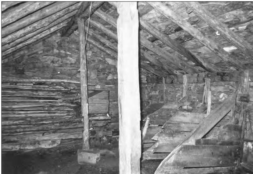
Figur 20. Steinfjøs med åsbærende midtstolpe. Sandvik, Selje i Fjordane. Foto: PG.
