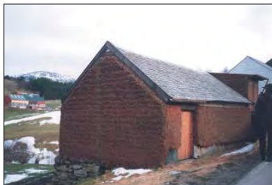
Figur 10. Brakekledd løe, Osterøy Foto: H.Schjelderup
