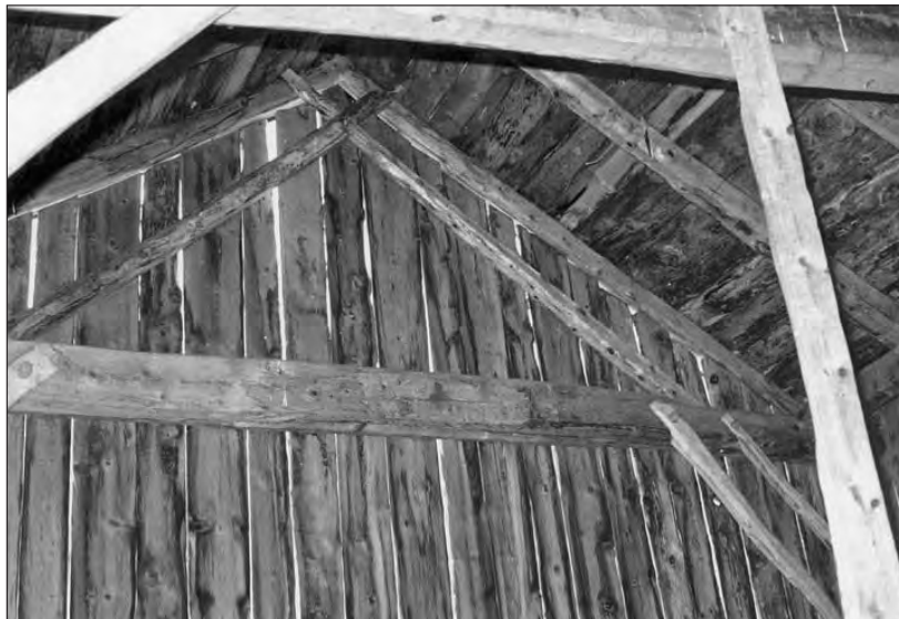
Figur 22. Gavlvegg i løe. Melheim, Eid i Nordfjord. Foto: FG.
