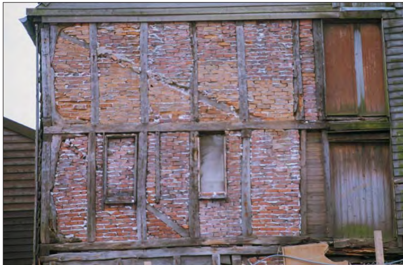
Figur 7. Sjøhus med utmurt bindingsverk som brannbeskyttelse, ca. 1860. Verkgaten i Stavanger. Foto: HS
