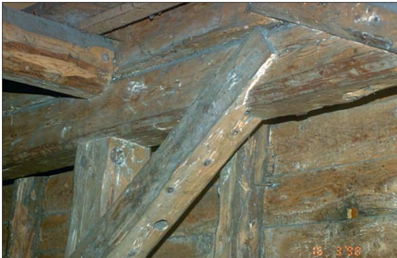
Figur 4. Fra interiøret på løa på Ålesund Museum. Et atypisk eksempel på nordmørsk stavlinekonstruksjon på Sunnmøre. Et resultat av innvandret håndverker? Foto: Ragnar Albertsen, Fylkesfotoarkivet.
