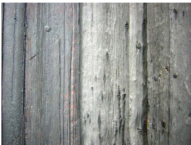
Bild 76. Del av panel på Sodankylä gamla träkyrka. Till vänster nykliven panel, till höger delar av den gamla panel som kyrkan delvis var klädd med före restaureringen 1995. Foto: H. Åberg
