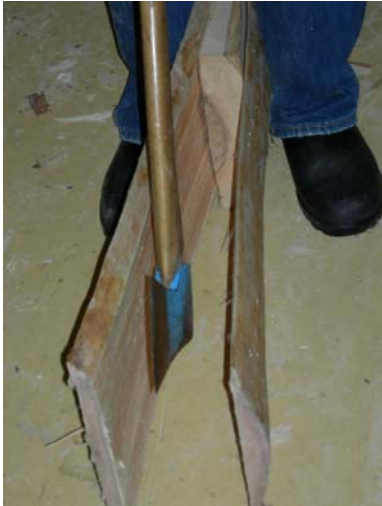
Bild 50. Klyvning av spanssevp med ämnet på högkant. Furustock 4. Foto: T. Karlsson
