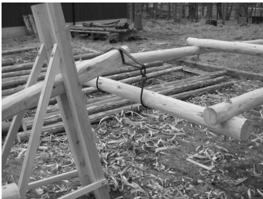
Bild 90: Lyfter första segmentet. Avståndet mellan krokarna ger bra stabilitet.
