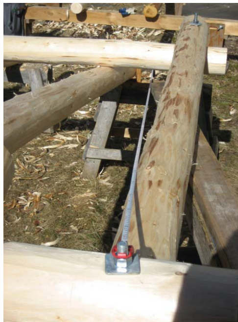
Bild 60: Mäter ut urtaget till låsbjälken i andra segmentet.
