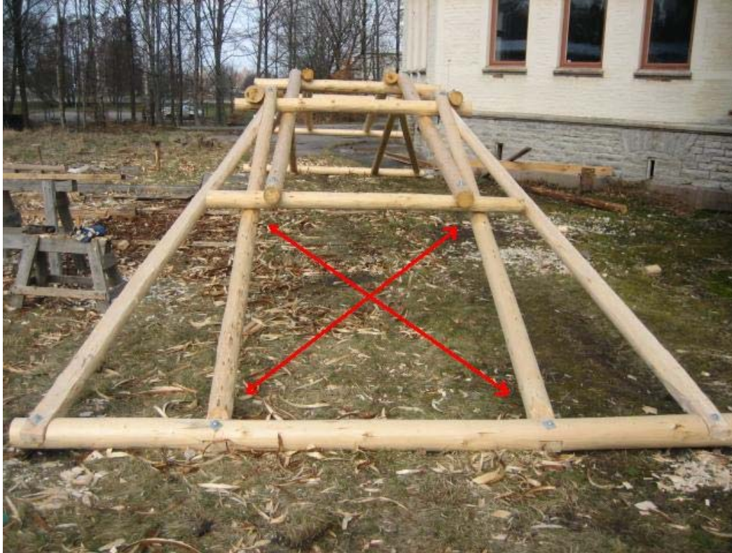
Bild 76: Strävorna på plats. Pilarna visar var krysstaget ska sitta.
