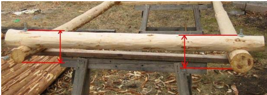
Bild 54: Pilarna visar utjämnningen.
