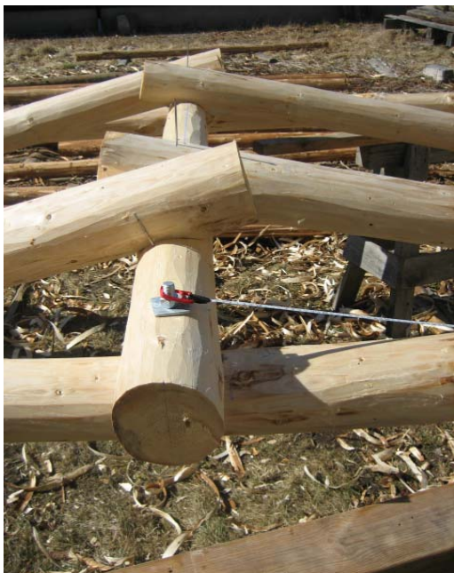
Bild 59: Den mittersta låsbjälkens bultskalle som utgångspunkt.
