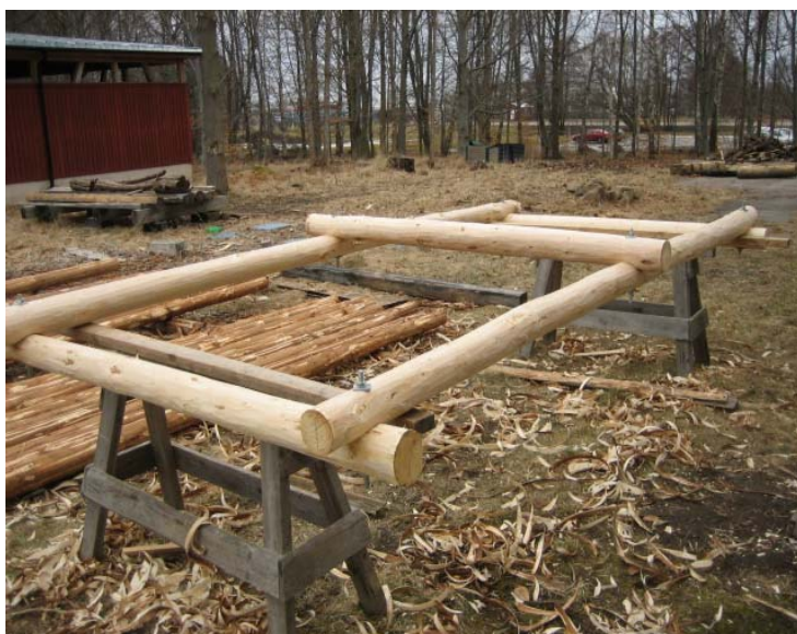
Bild 57: Sista låsbjälken på plats. Segmentet rättvänt
