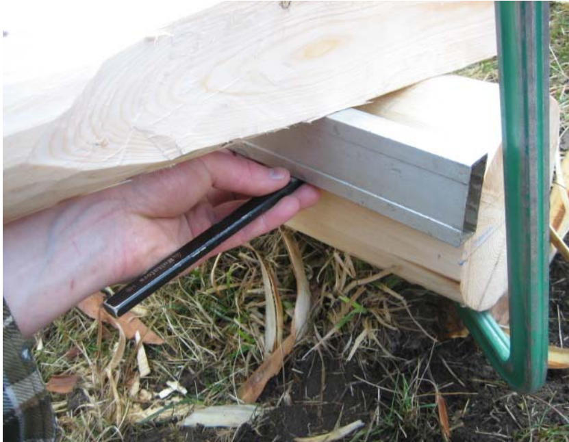
Bild 84: Urtagets djup ritas med vattenpasset som ligger dikt an mot strävans undersida. Detta gjordes på båda sidorna.
