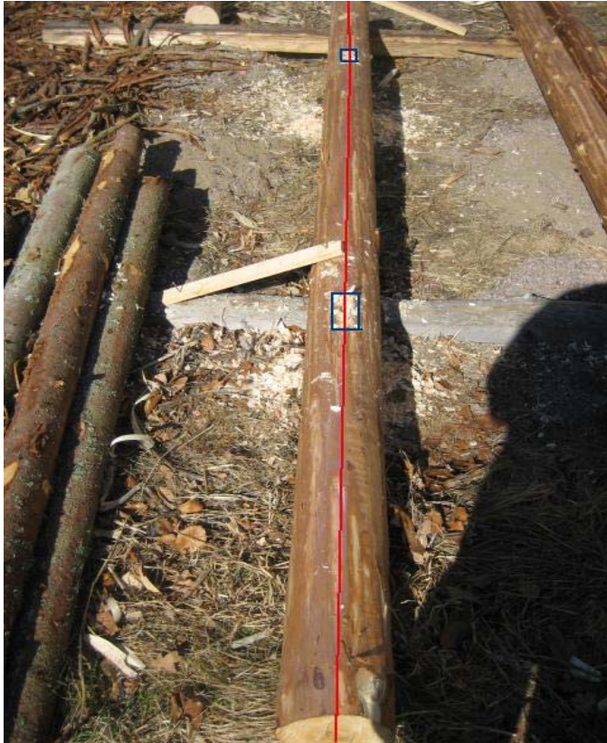
Bild 69: Lodlinjen och den snörslagna linjen mellan stockens ändar. De markerade rutorna visar tapphålen.
