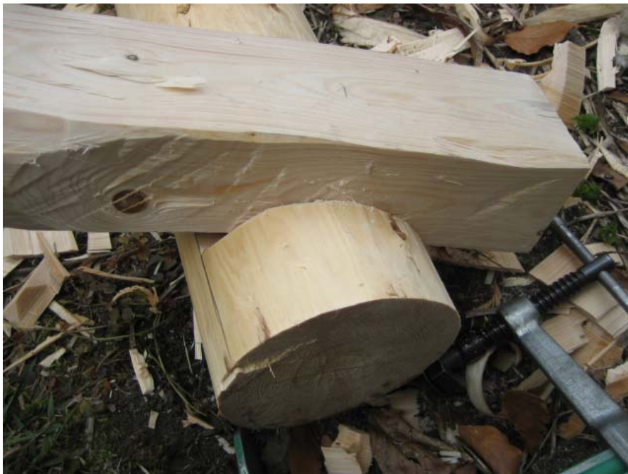
Bild 85: Snedsträvan är nedfäld i fundamentstocken.
