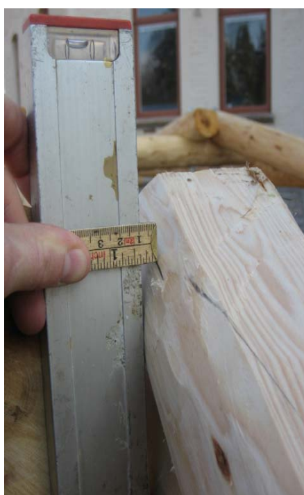
Bild 80: Måttet sätts av på övre stocken. För att få ut syftlinjen
