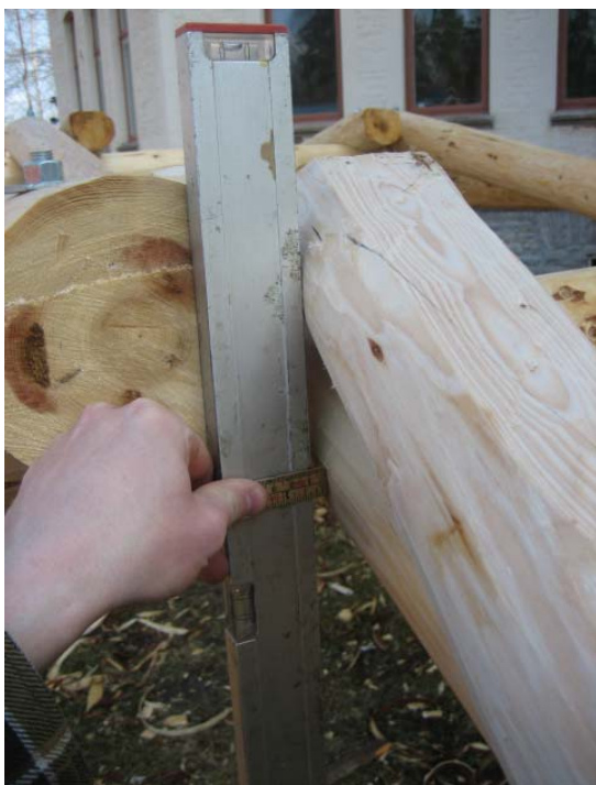
Bild 79: Toppänden. Utifrån lodlinjen tog jag ut måttet från den undre stocken.
