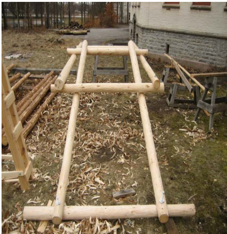
Bild 61: Urtagen är klara och den korta låsbjälken på plats.
