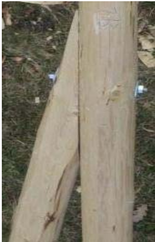
Bild 78. Visar snedsträvans övre del nedfälld mot sidan av tappstocken sett från ovasidan.
