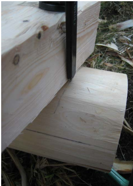
Bild 83: Strävans läge markeras på var sida med hjälp en penna.
