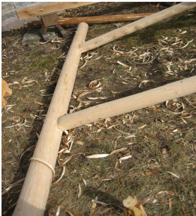
Bild 72: Fundamentstock och segmentet på plats i brokonstruktionen.
