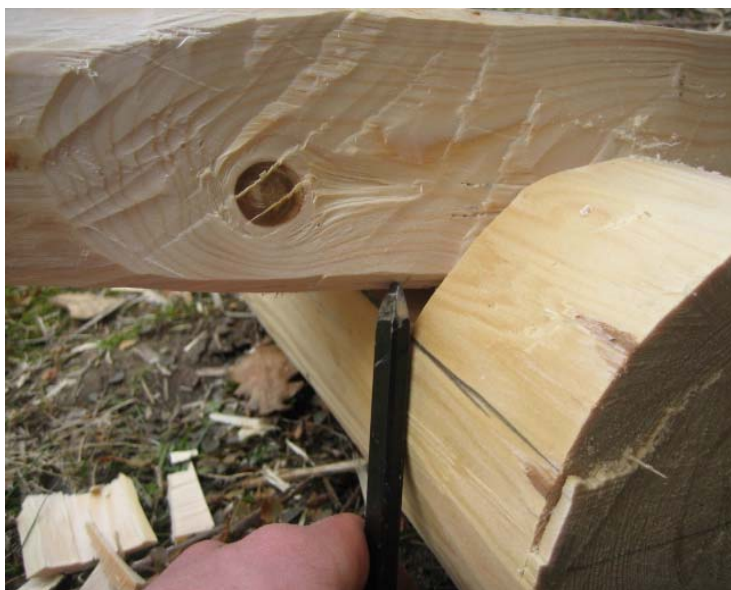
Bild 86: Strävans klack ritas utefter fundamentstocken.
