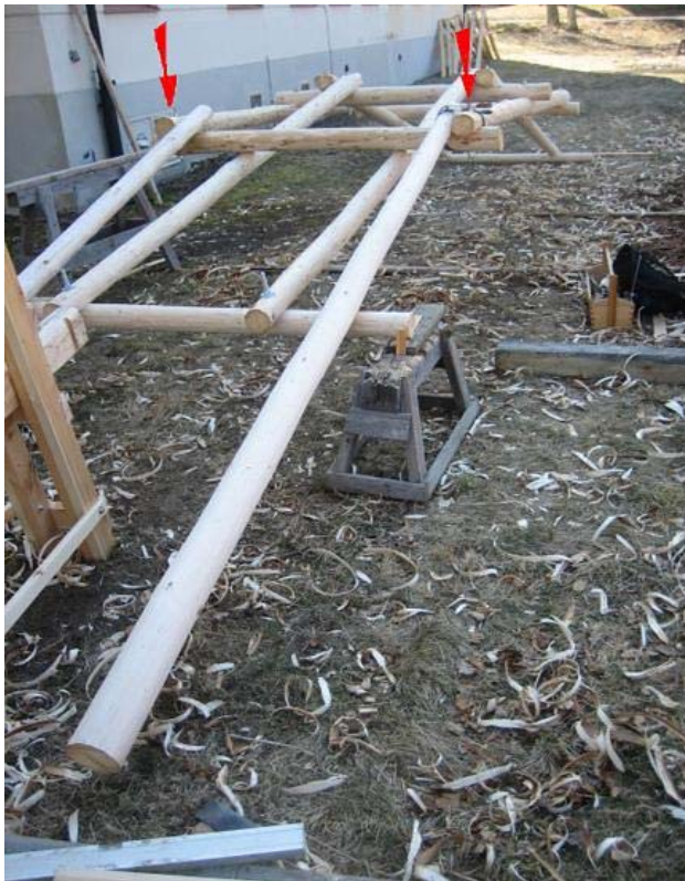
Bild 65: Tredje segmentet vilar på bockarna, pilarna visar vilka bultar som jag mätte ifrån.
