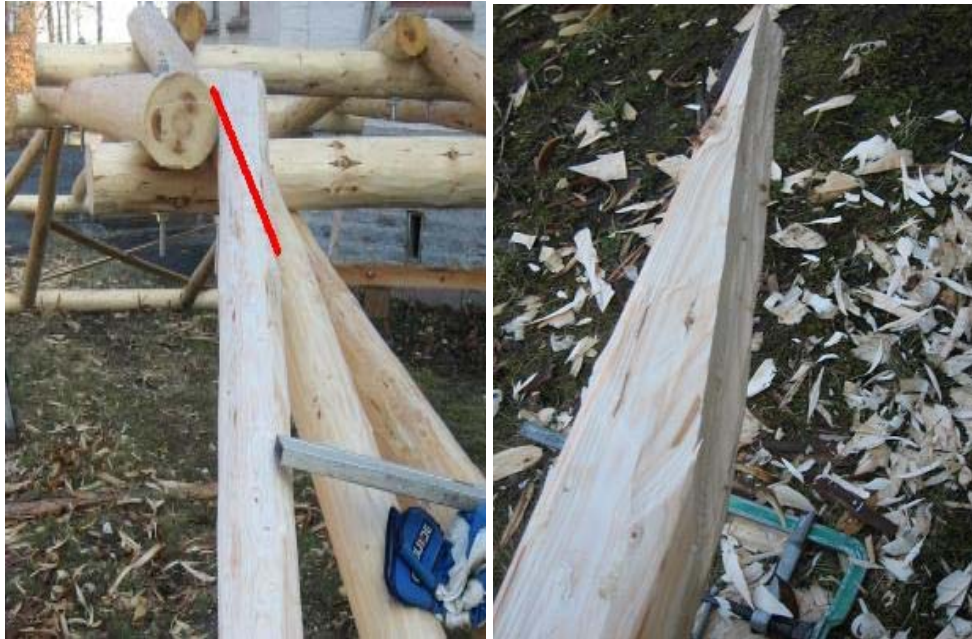
Bild 81: Min syftlinje efter den undre stocken Bild 82: Snedsträvans liggyta något urgröpt. kraftigt markerad.
