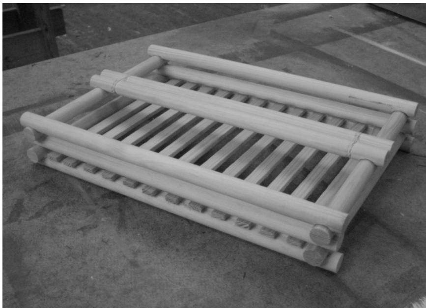
Bild 38: Typ 5. En stenkista som kan användas till de platser där bärförmågan i marken inte är tillräcklig och där det är bättre att bygga direkt i vattnet. Kistan är timrad och med grova plankor i botten.
