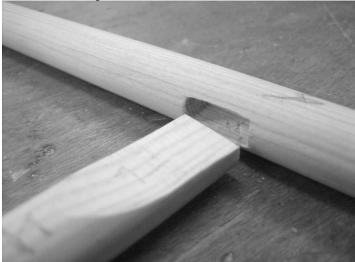
Bild 11: Detaljbild av tapp och fundamentstock. Dess rektangulära tapp och hål.
